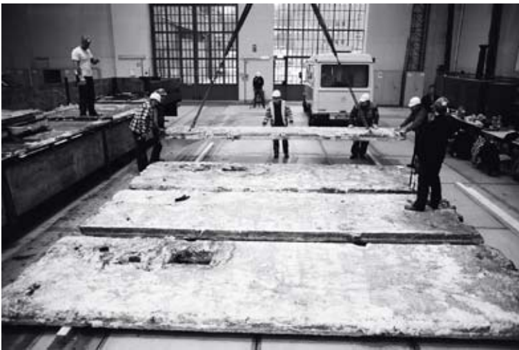
Anlieferung von Platten aus Frankfurt/Oder
