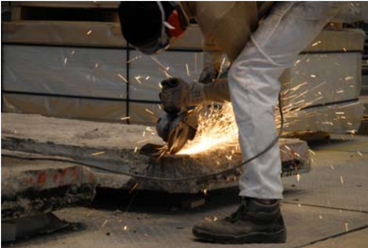
Überarbeiten der Bauteile
