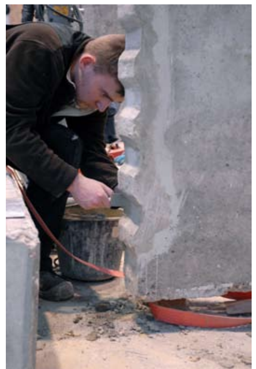
Betonkosmetische Ausbesserung der Platten
