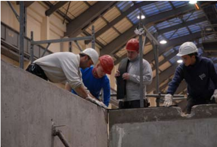
Vorbereitungen für die Auflagerung der Zwischendecke
