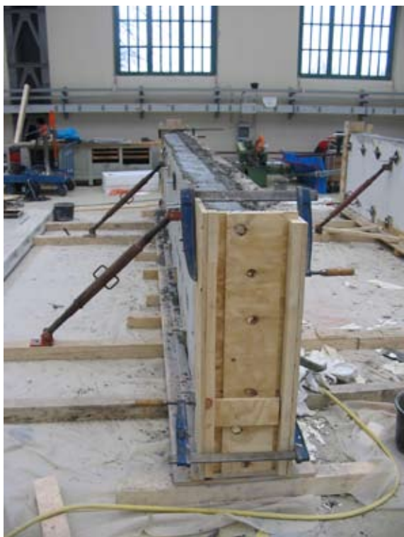
Herstellung der Sandwich-Decken
