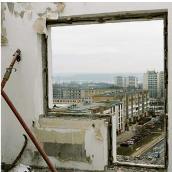
Blick aus dem Abrissgebäude in Frankfurt/Oder
