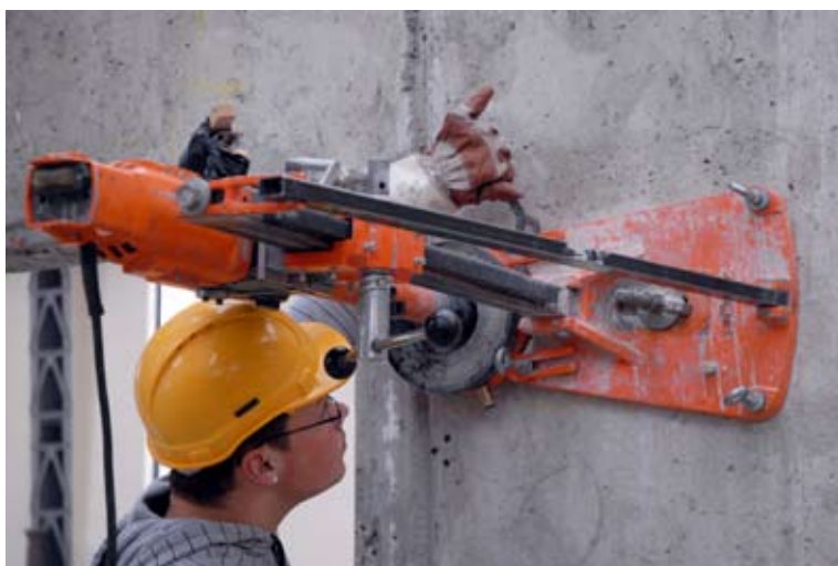
Setzen von Kernbohrungen
