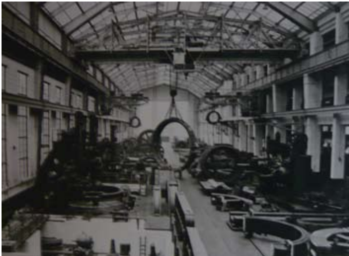
Historische Ansicht der AEG-Halle
