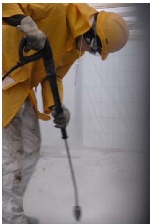
Grobreinigung der Platten mit Hochdruckreiniger
